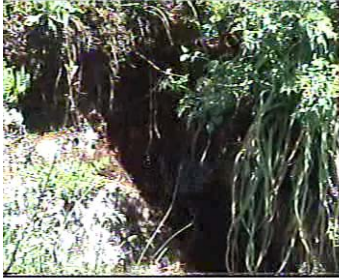
Figure 12 : Action du ruissellement sur un talus à moitié dévégétalisé
