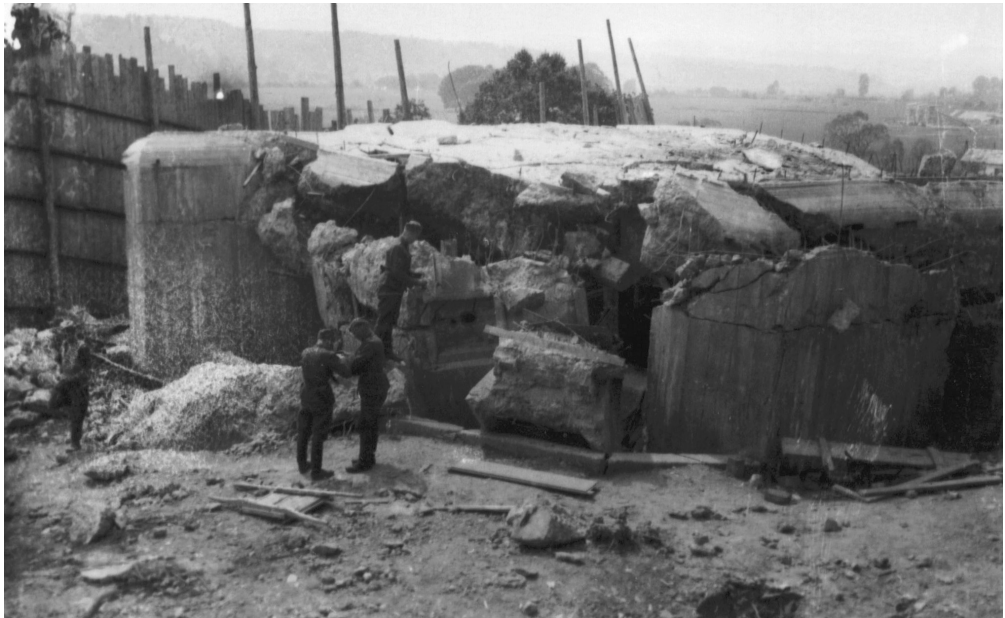
13. Sovietske železobetónové bunkre na západných hraniciach (tzv. Molotovova línia) neboli skutočnými pevnosťami. Pohľad na jeden z bunkrov, ktoré deštruovali slovenskí ženisti začiatkom júla 1941. Zdroj: Osobný archív autora.
