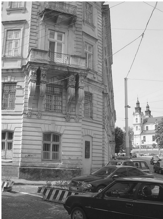
58. Budova niekdajšej väznice na Lonského (Łączkiego) ulici. Dnes tu visí pamätná tabuľa obetiam NKVD, gestapa i MGB.
