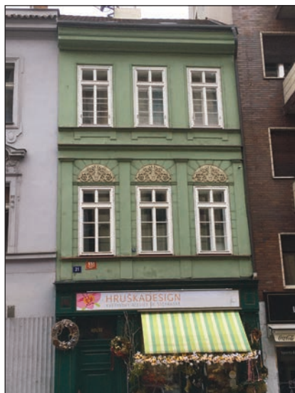
Budova bývalé vinárny U Labužníka v pražské Štěpánské ulici 21 (Zdroj: Archiv A. Zítka)
