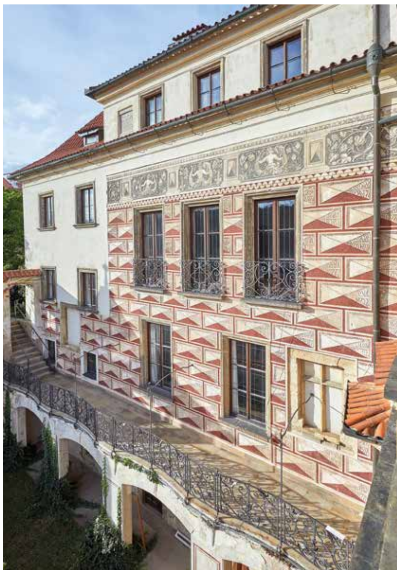
Jižní průčelí koleje barnabitů na Hradčanech. V padesátých letech byly analyticky odhaleny pozůstatky gotických oken a doplněna nová sgrafita. Kovaná zábradlí balkonu a oken pocházejí až z osmdesátých let minulého století. Vedle západní průčelí jižního kolmého křídla koleje, 2020. (foto: Ondřej Němec)
