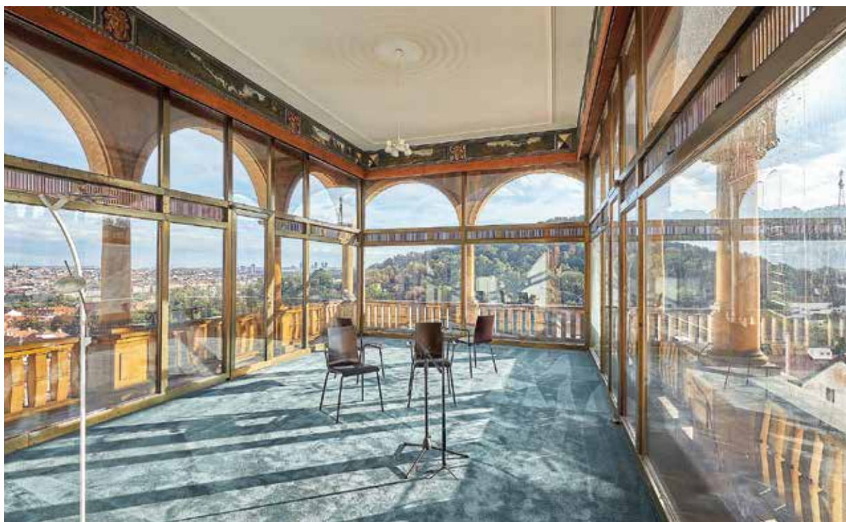
Vyhlídkový pavilon. Do prostoru znovu vystavěné lodžie byla v padesátých letech minulého století vsazena poměrně subtilní prosklená kovová konstrukce, která byla v osmdesátých letech nahrazena novou. Pod stropem byl vytvořen historizující malovaný vlys, 2020. (foto: Ondřej Němec)
