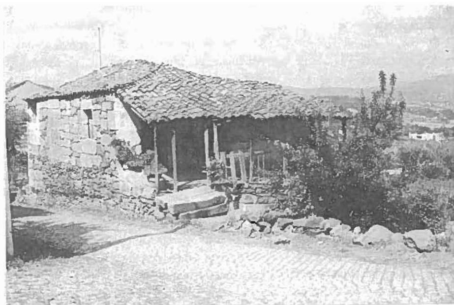
Imóvel em ruínas conhecido, desde tempos imemoriais, como a “Casa de Camões”.
