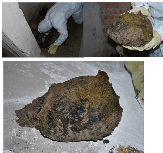
Foto 1: recuperación de restos de descuartizamiento de red cloacal
