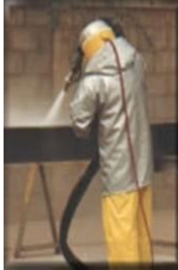
Figura 4. Limpieza con chorro abrasivo grado metal blanco
