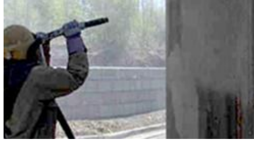
Figura 6. Limpieza con chorro abrasivo grado comercial
