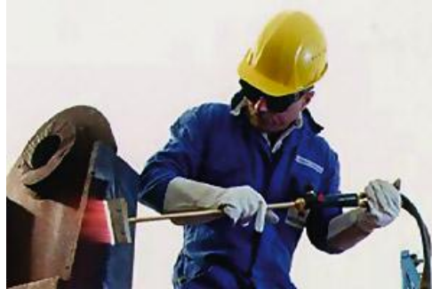
Figura 8. Limpieza con flama
