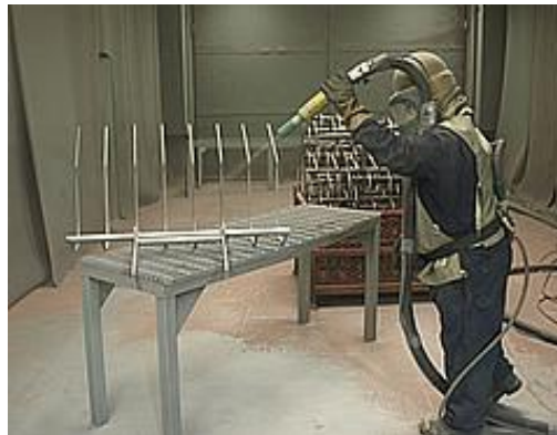
Figura 15. Limpieza con chorro de aire
