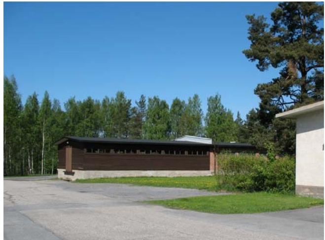
V2:n puuverhoiltu pääty.
