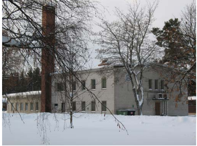
ATK-keskus koillisesta. Helmikuu 2010.
