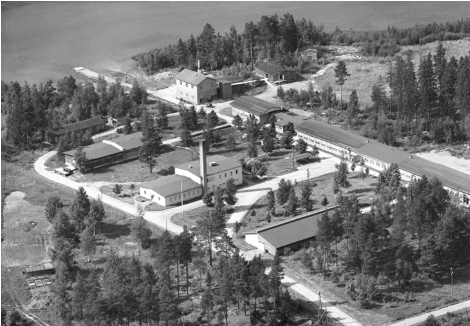
Vanha myllyttämö kuvan yläreunassa. Ilmakuva vuodelta 1961.
