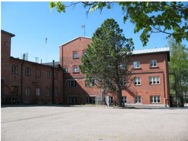
Tehdas pohjoisesta. Uusin laajennus oikealla. Toukokuu 2010.
