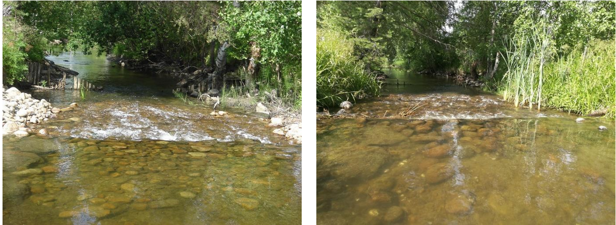
Kuva 15. Ormijoen pato kesällä 2006 ja kesällä 2017. Vuoden 2006 kuvassa erottuu padon takana vanhan padon puisia rakenteita. Ainakin pienten kivien määrä padon edustalla näyttää vähentyneen.
