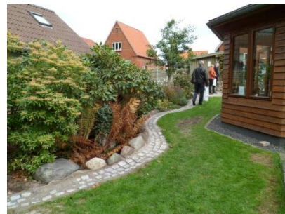
Billede 4: Tilledning kanal til regnbed
