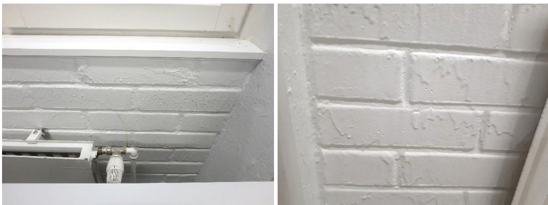
Kuva 20. Ulkoseinärakenteiden sisäkuoren tiilipinnat oli käsitelty ilmatiiviiksi.
