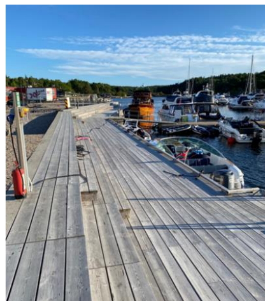
Figur 5-5: Eksempel på utforming av landareal med vertikal sjøfront ved småbåthamn. Fyllinga (til venstre) ligg på flaumsikkert nivå medan brygga kan verte overflødd under stormflo. Foto: Norconsult AS.
