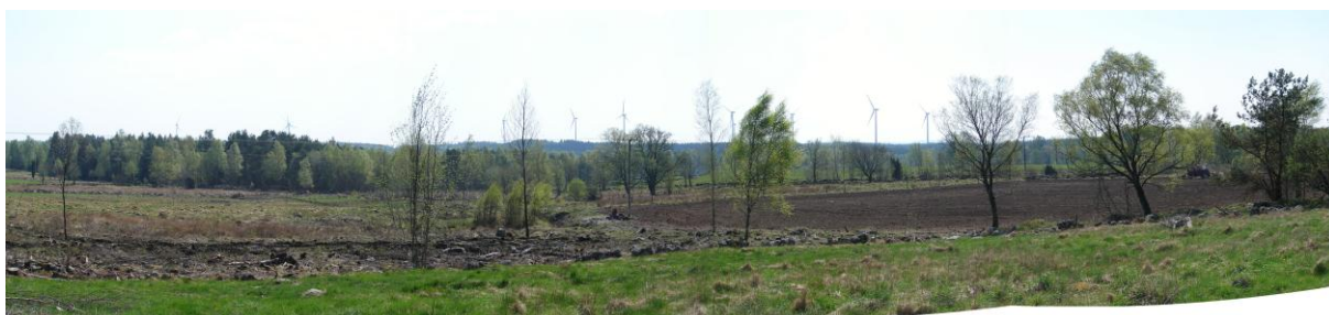
Vindkraftverk i skogslandskap som omger ett öppet småskaligt landskap. Bilden visar Oxhultsparken i Hishult, Laholms kommun. Vindkraftverkens tornhöjd är 105 m, totalhöjden ca 150 m.
