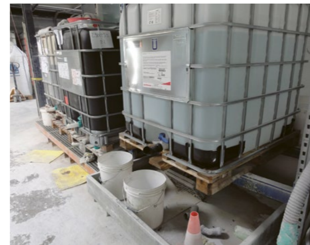
Stockage de réactifs pour le prétraitement d'effluents industriels
