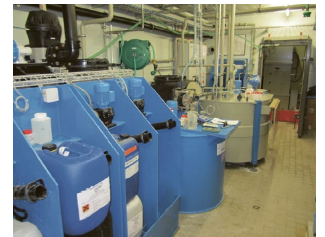
Stockage de réactifs pour le prétraitement d'effluents industriels
