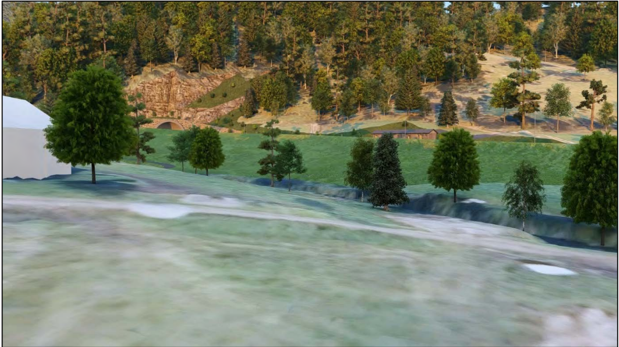
Figur 3–10: Tunnelmunningsområde ved Storehaugen sett frå bakkenivå på gardstunet på Myra, som ligg vest for ny E39 (Ill.: Multiconsult / Statens vegvesen).
