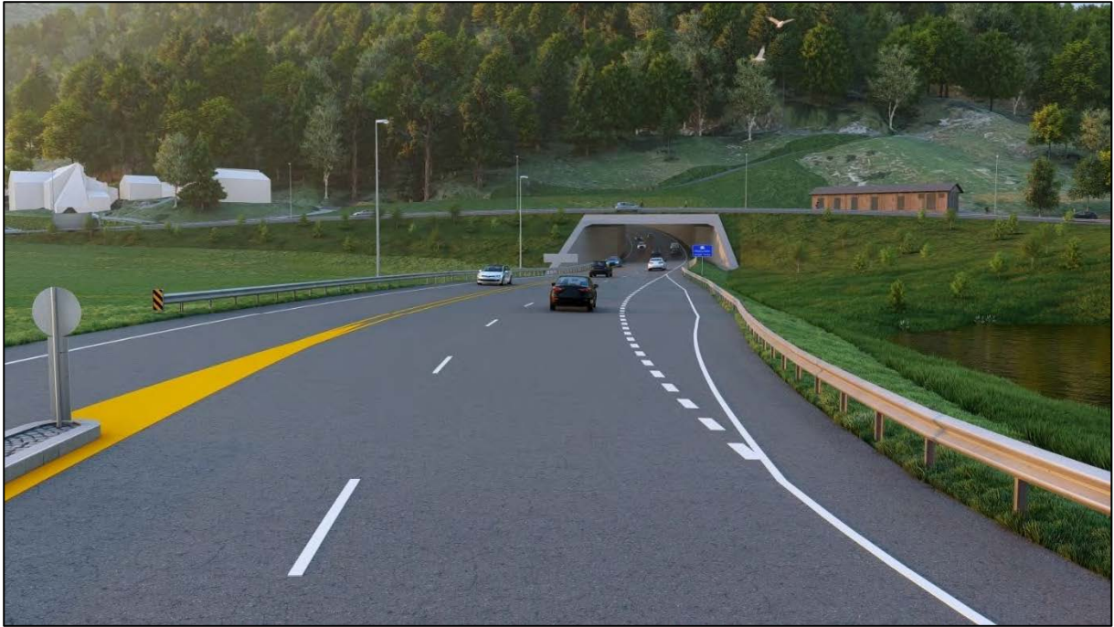
Figur 3–19: Tunnelmunningsområde på Bruland sett frå aust (ved rundkøyringa). Ny E39 ligg i nivå med dagens E39 og lokalveg går over tunnelportal. (Ill.: Multiconsult / Statens vegvesen).
