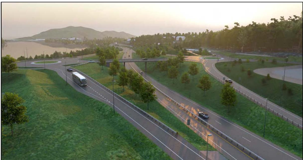
Figur 4-9: Visualisering av planskilt kryss på Storehaug. Ein ser for seg parklikt areal med tregrupper i areala mellom dei to rundkøyringane og europavegen. (Illustrasjon Multiconsult/Vegvesenet)
