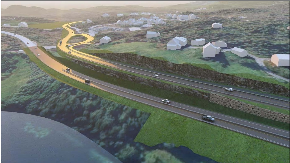
Figur 3-14: Eksisterande kryss mellom E39 og fv. 57 som kan skimtast i øvre venstre del av illustrasjonen, vert fjerna, og fylkesvegen vert ført fram til nytt kryss ved Storehaugen (utanfor høgre biletkant). (Ill.: Multiconsult / Statens vegvesen)
