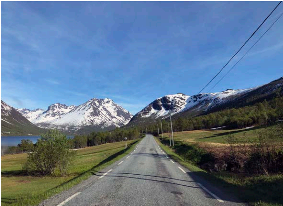
Fylkesvegen på vestsiden av Ramfjorden mot Sørbotn fra juni 2020. Dagens E8 går på andre siden av fjorden til venstre i bildet. Foto: Nils Petter Rusånes
