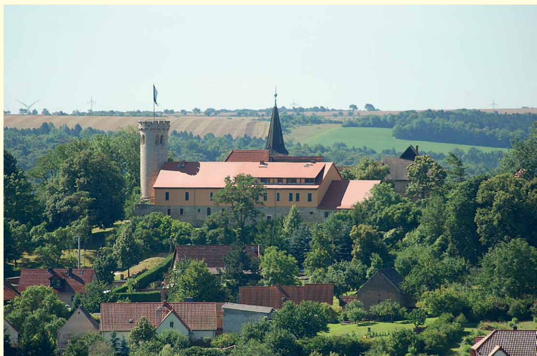
Blick auf das restaurierte Rittergut in Zscheiplitz – heute Weingut Pawis – mit Wassertrum
