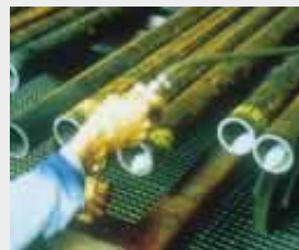
Einblasen von VCI-Pulver zum inneren Schutz von Rohren (F)
