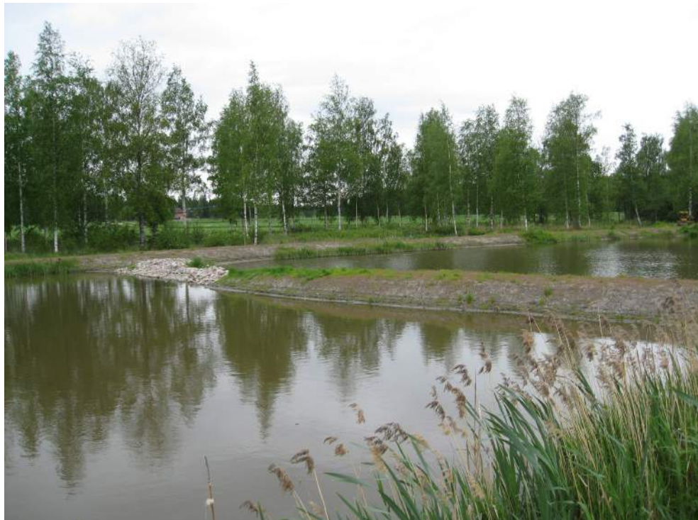
Kuva 24. Purailanviepän altaat on osoitus Kutajoen alueen talkoovoimasta (kohde 119). Hieno allaskokonaisuus on rakennettu Vesijärvi II -projektin aikana. Kuva: Johanna Vepsäläinen
