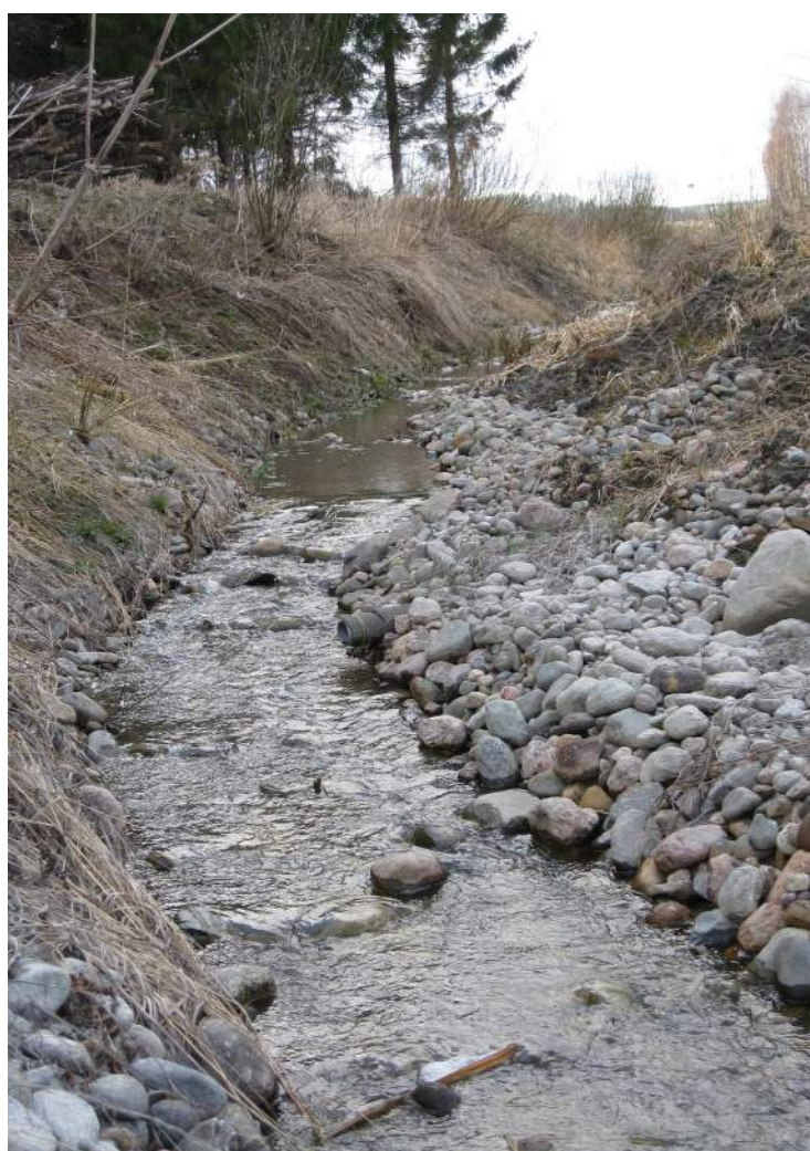
Kuva 7. Luonnonkivillä tehtyä eroosiokorjausta Rautaisenojassa. Kuva: Johanna Vepsäläinen
