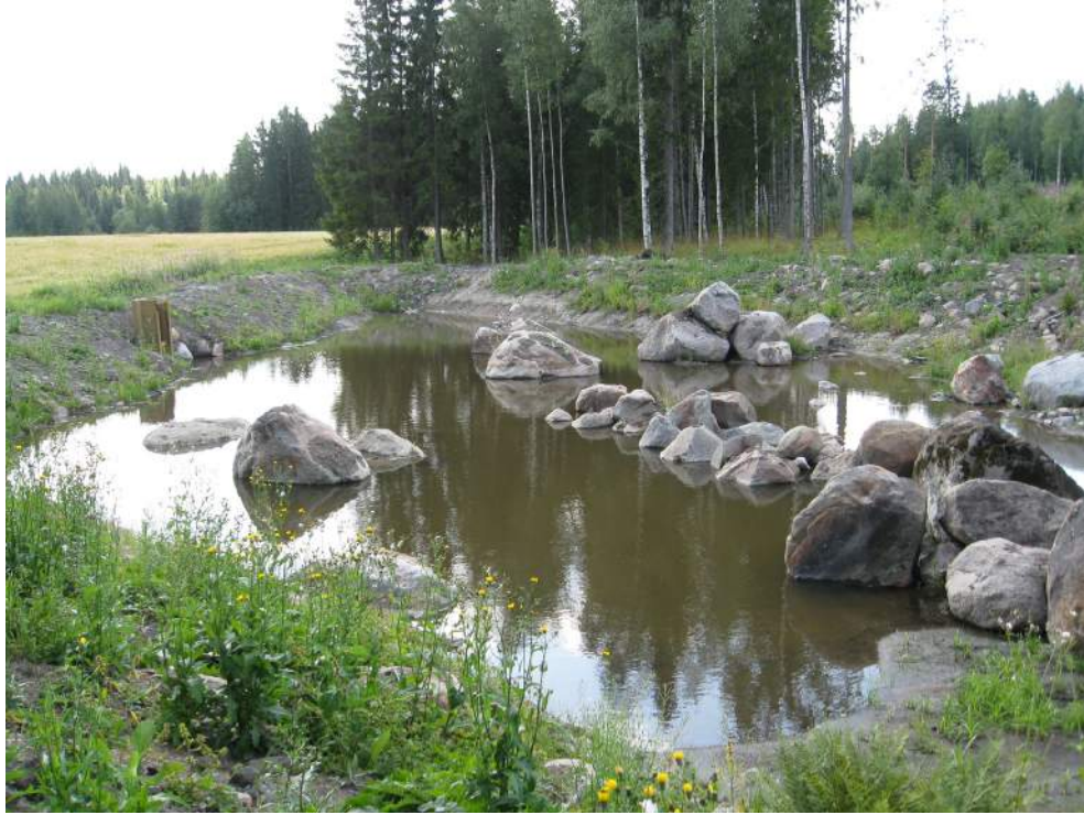
Kuva 27. Metsäkeskuksen ja Mustojan alajuoksun suojeluyhdistyksen yhteistyönä toteuttama laskeutusallas (kohde I40). Kuva: Hanna Eskola
