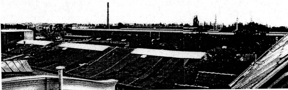
Über den Dächern von KAB: Links im Vordergrund ein Teil des Daches von Halle 7, am linken Rand der Steigerturm der Betriebsfeuerwehr und die neue Halle 37 der Expedition, nach rechts folgt der 40m hohe Schornstein des Heizhauses sowie die Hallen 1 und 4, rechts die 3 Entlüftungsrohre der neuen Farbgebungsanlage.
