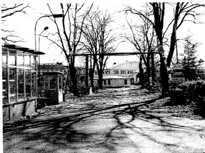
Ein- und Ausgangsbereich vom „Kühlautomaten“ heute (April 2000)
