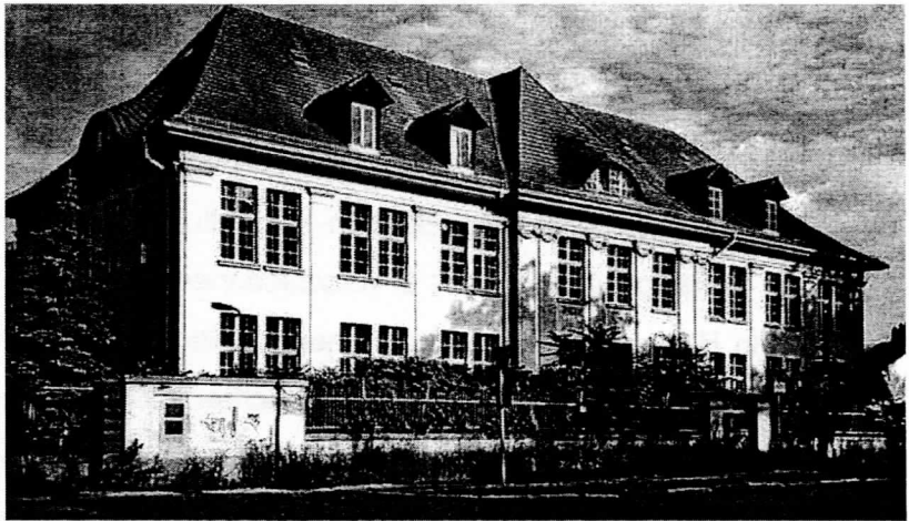
Verwaltungsgebäude des VEB Kühlautomat Berlin, vormals LVG
