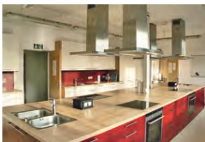
Schulküche der vhs Vaterstetten
