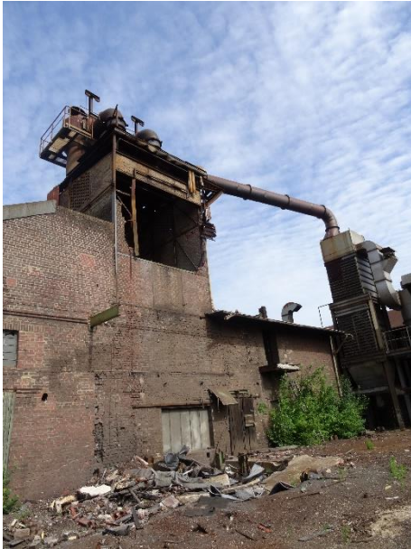
Abbildung 9: Außenansicht der Eisengießerei, Quelle: ISR 2019
