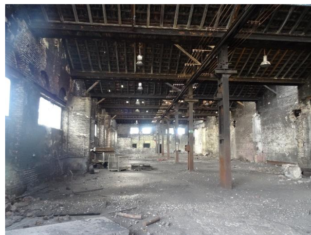
Abbildung 8: Innenraum der Eisengießerei, Quelle: ISR 2019
