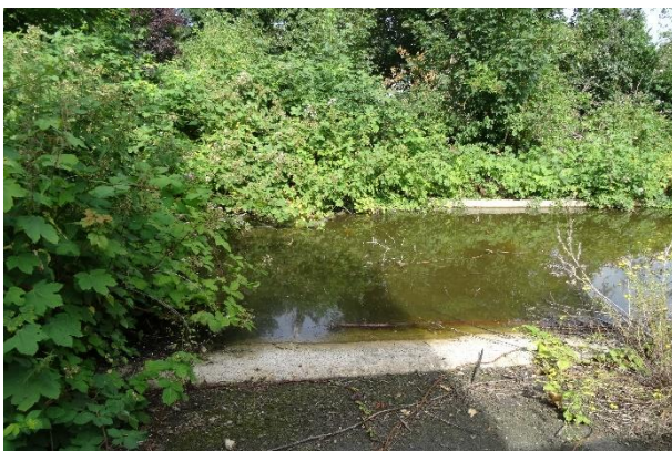
Abbildung 13: temporär wasserführende versiegelte Fläche hinter der Eisengießerei (westlich), Quelle: ISR 2019
