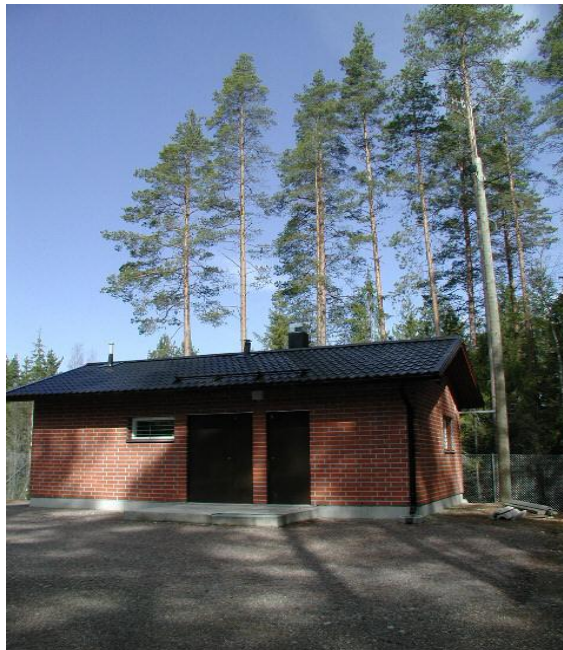
Kuva 8. Lankilan vedenottamon käsittelyrakennus
