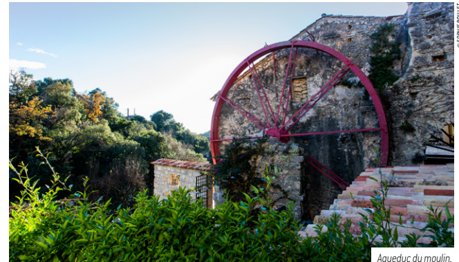
Aqueduc du moulin.
