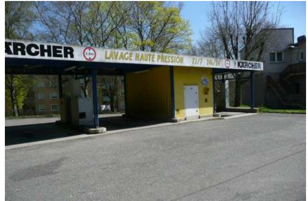
Station de lavage très peu qualitative en entrée de ville. Aucune gestion de la limite avec l'espace public
