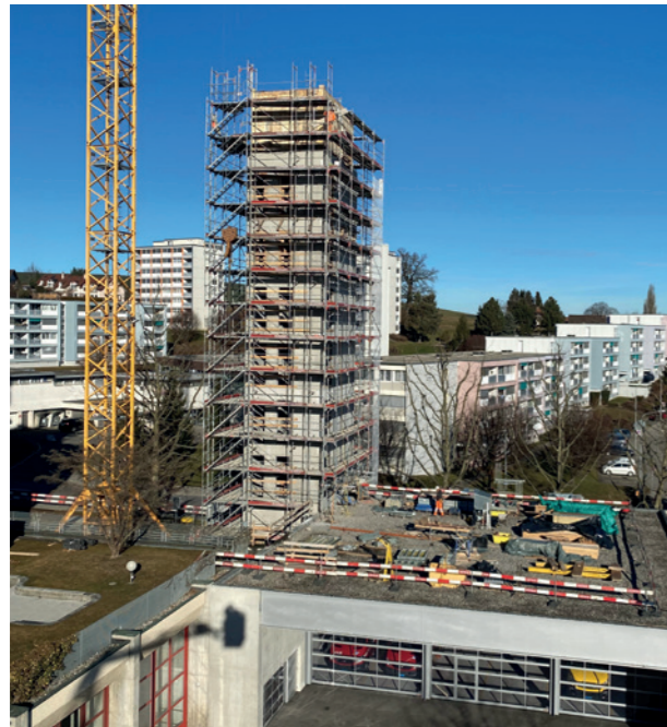
Das BATPOL-Gebäude im Bau
