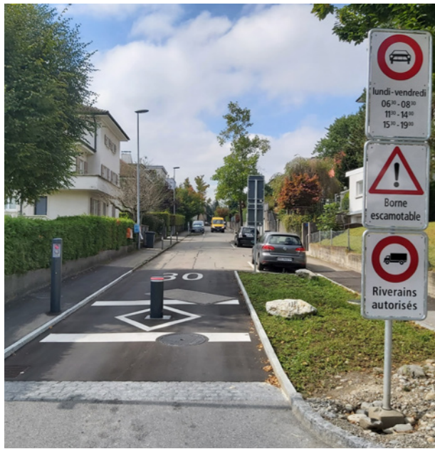
Der neue versenkbare Poller der Route de la Vignettaz
