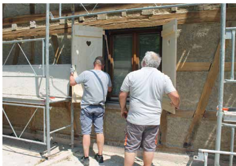
Essai des volets fabriqués sur mesure, avant peinture au sein des ateliers municipaux
