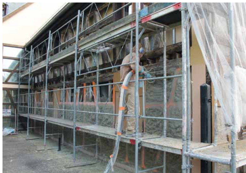
Projection de chaux et de chanvre
