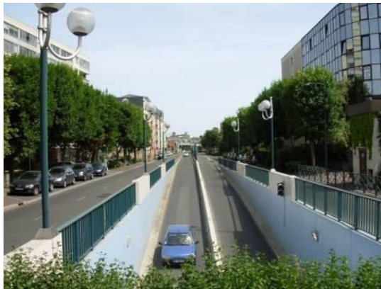
La RD 14 au niveau du Carrefour de l'Insurrection
