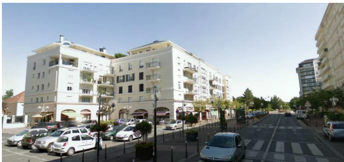
Vue depuis l'avenue Berthie Albrecht
