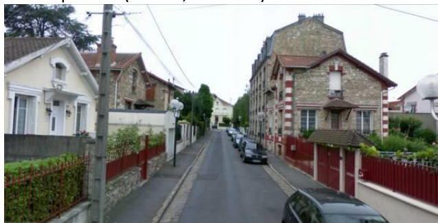
L'habitat pavillonnaire de la rue de la Sœur Angèle
