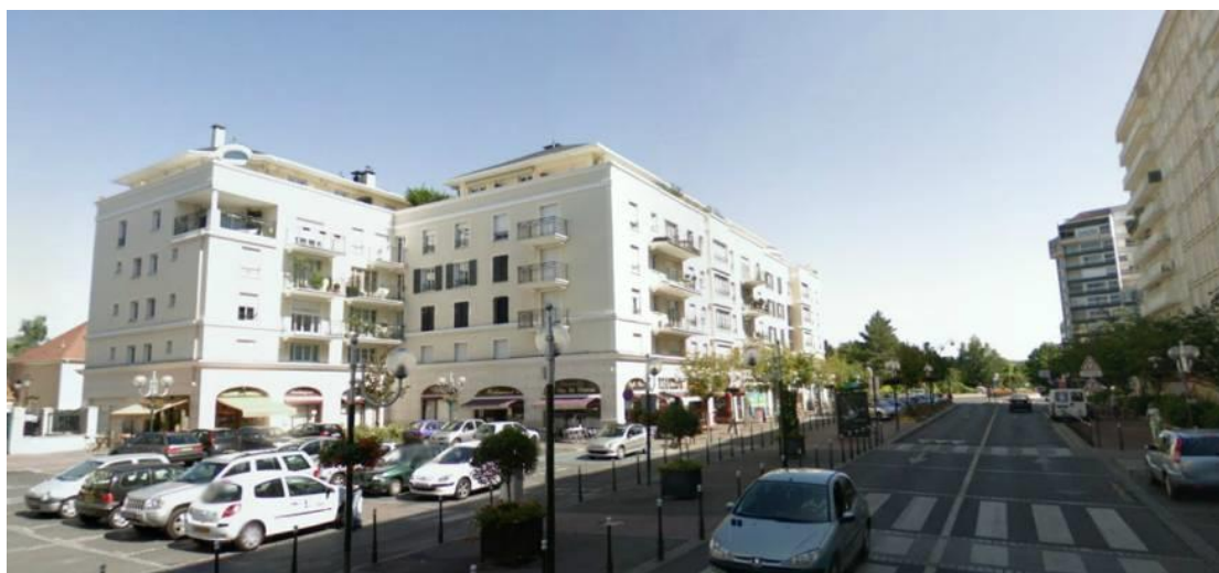
Vue depuis l'avenue Berthie Albrecht
