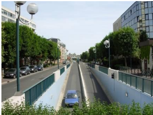
La RD 14 au niveau du Carrefour de l'Insurrection
