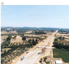
1 La concession de l'autoroute Athènes-Corinthe-Patras s'agrandit de 75 km jusqu'à la ville de Pyrgos.
