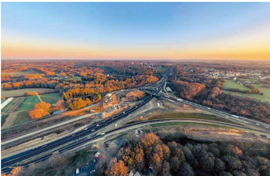
Réaménagement de la porte de Gesvres, à la jonction de l'A11 et du boulevard périphérique de Nantes, réalisé dans le cadre du Plan d'investissement autoroutier.
