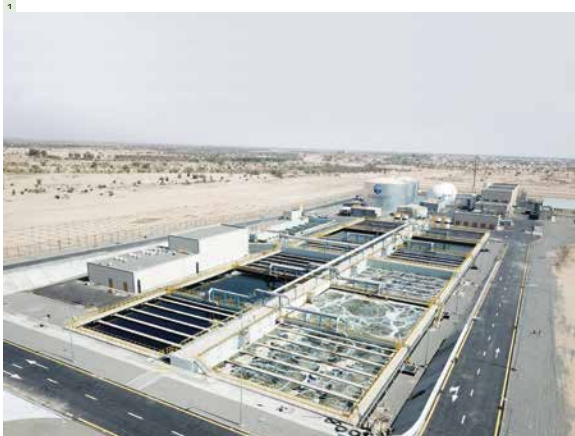
1 Construction d'une usine de traitement des eaux usées en Arabie saoudite d'une capacité de 100 000 m 3 par jour, extensible à 270 000 m 3 .
