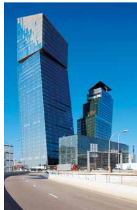
Réalisation par VINCI Construction, des tours DUO, hautes de 180 m et 122 m, qui parachèvent la dynamisation du quartier Masséna (Paris 13 e ).
