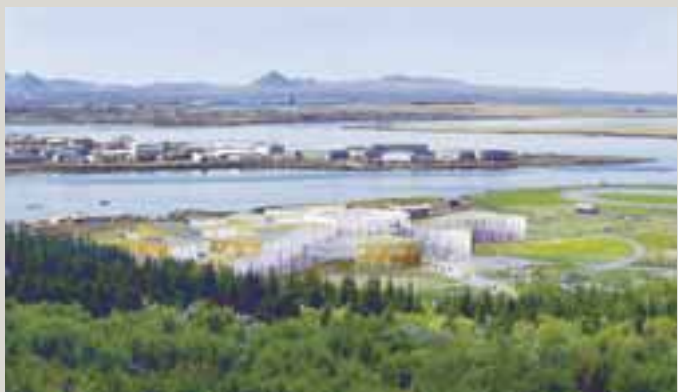
FRÁ ÖSKJUHLÍÐINI Hugsunin bak við teikningu skólans var að hann væri lágreistur og félli vel inn í umhverfið í Vatnsmýrinni.
