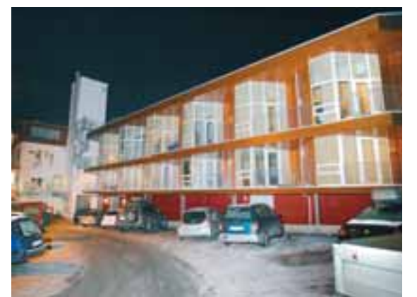
VIÐ HRINGBRAUT Mannlátið átti sér stað í húsnæði við Hringbraut.
