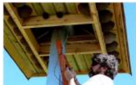
Branchement de haut-parleurs sur une tour à hirondelles de fenêtre © LPO Moselle
