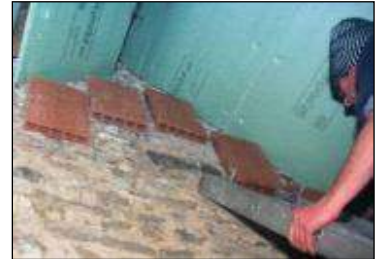
Pose de briques creuses dans une maison forestière © GMB
