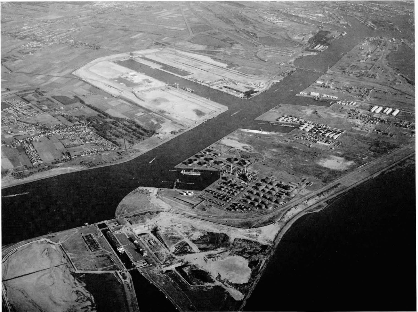
Luchtzicht van het noordelijk havengebied. Vooraan de Zandvlietsluis, met daarnaast de bouwput van de Berendrechtsluis. In het midden van de foto bemerkt men het Delwaidedok, waar de nieuwe installaties worden opgebouwd. Helemaal bovenaan : het Churchilldok en een aantal andere dokken.
