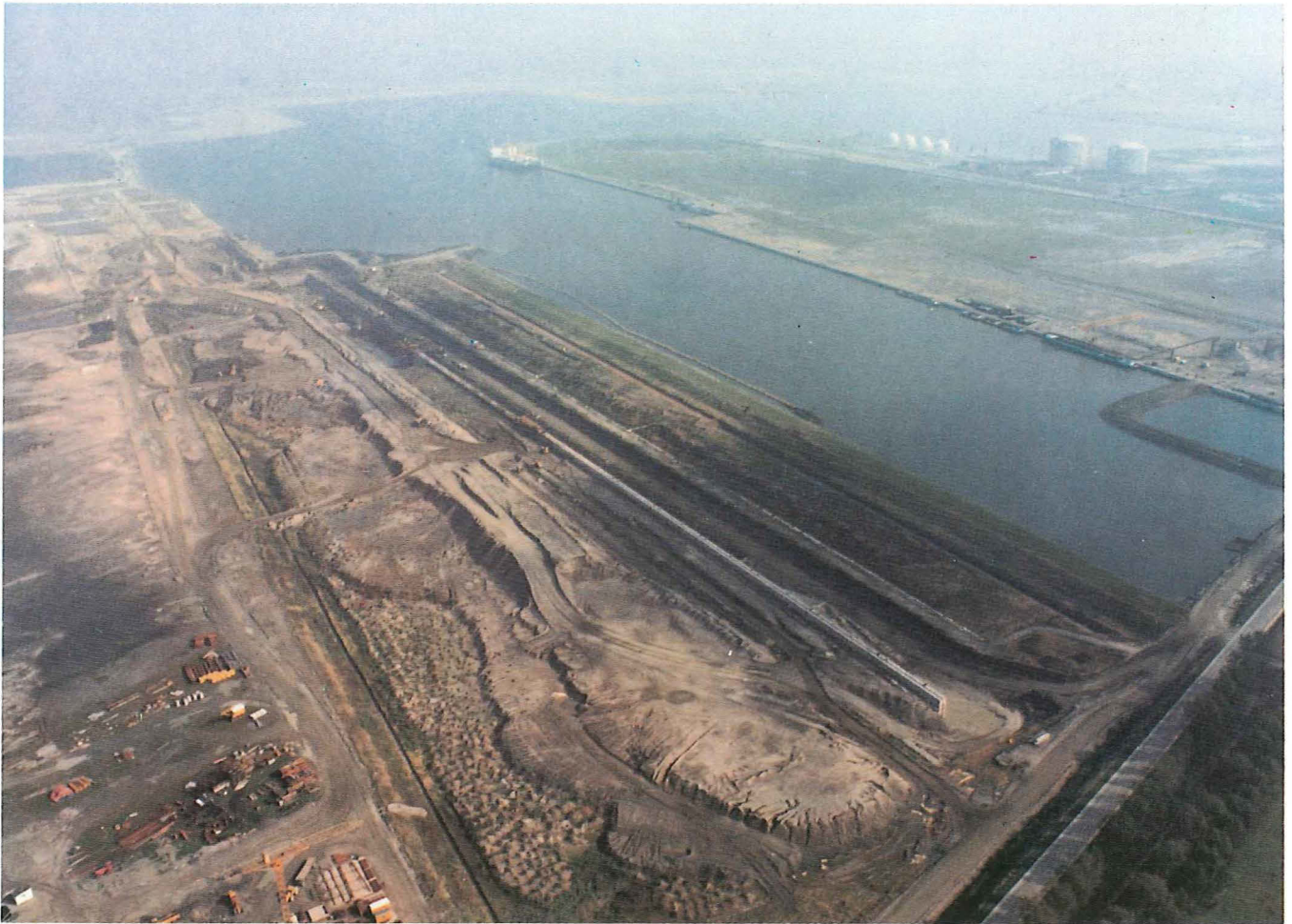
Le bassin dit « Vrasenedok ». A l'avant-plan le chantier 3 e phase.
