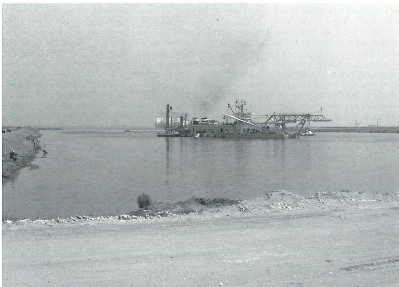
Bassin dit «Vrasenedok» en cours de dragage.
