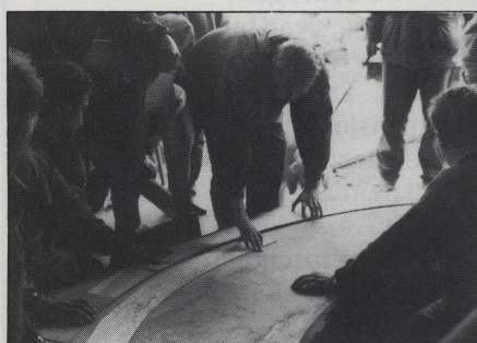
De mallen worden afgetekend op de massieve plank waar de voorsteven zal uitgezaagd worden.
