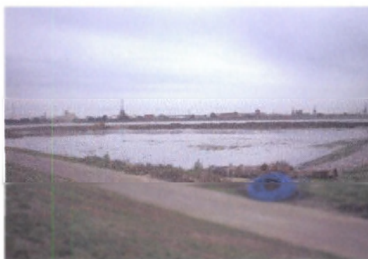
Overzicht van het slibbekken
