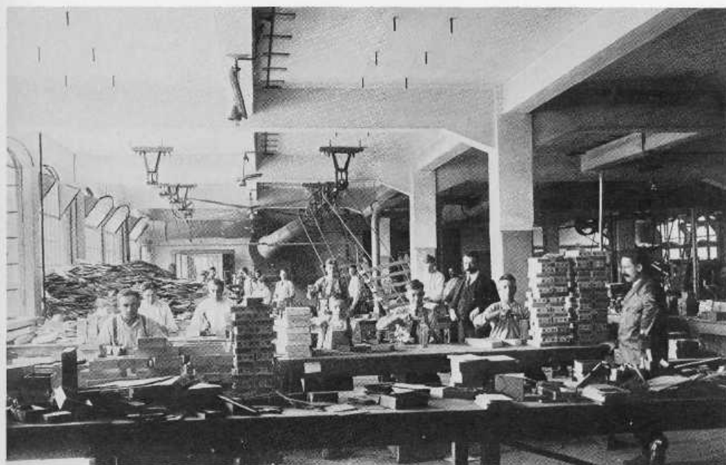
Zoals uit de betonconstructie blijkt, was de Imprimatur een zeer moderne fabriek. Hier de afdeling waar de sigarenkistjes worden gemaakt. Bij de pilaar opzichter Piet Siebers. (foto ca. 1920)
