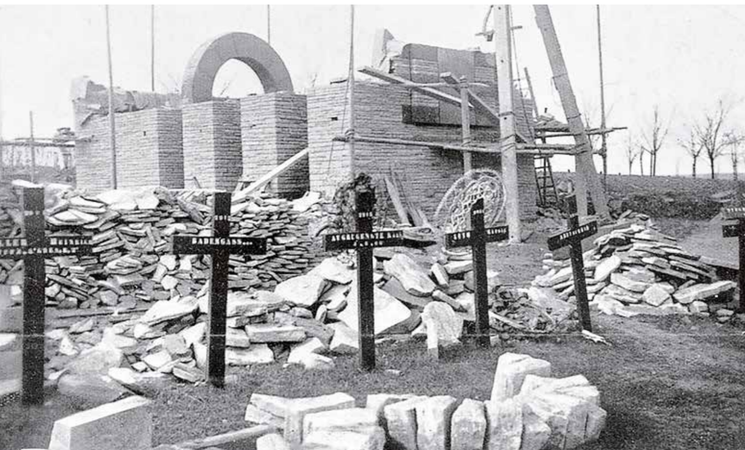
Bau der Kapelle auf der Kriegsgräberstätte Rancourt, Frankreich
