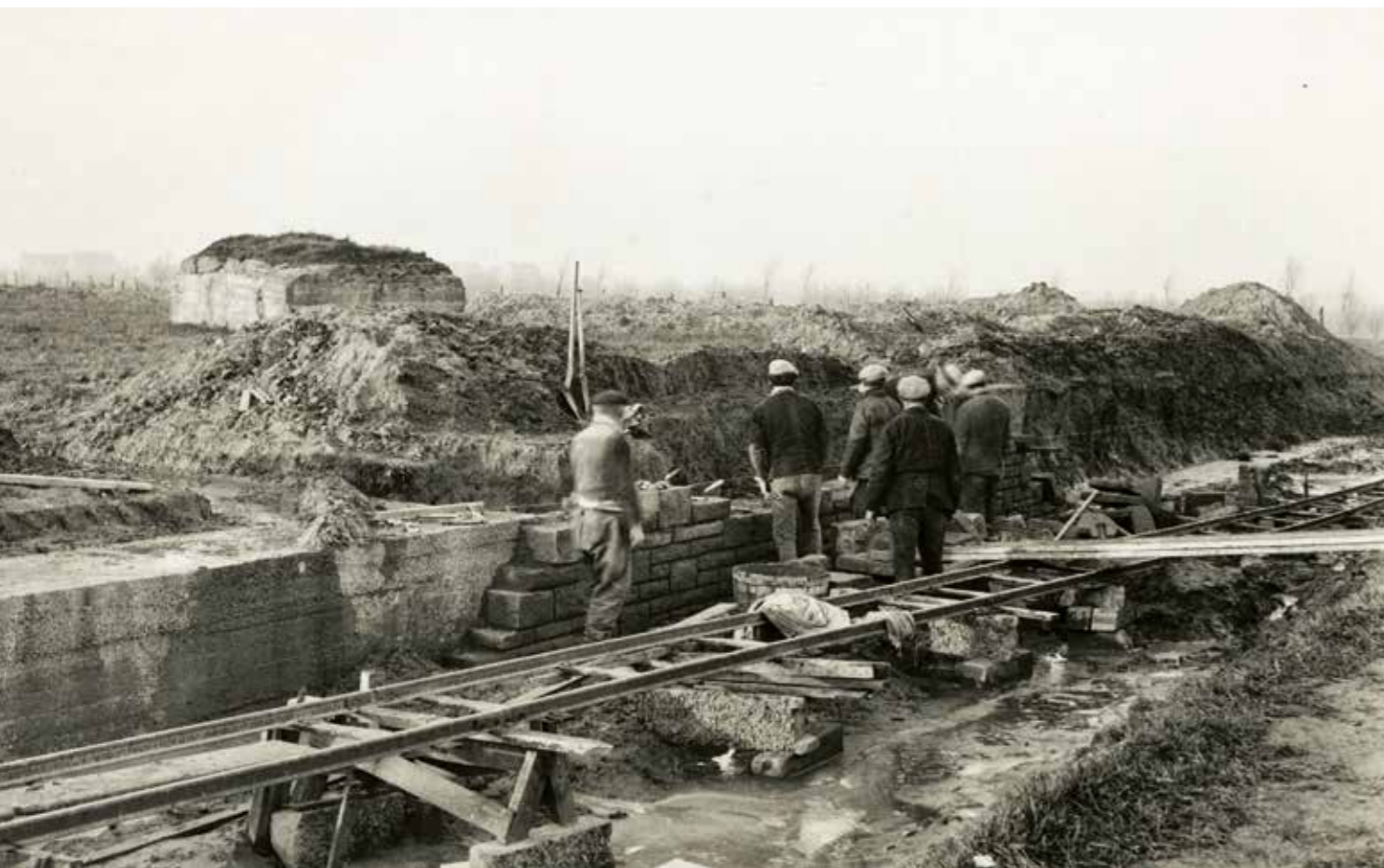
Bauarbeiten auf dem Friedhof in Langemark/Belgien
