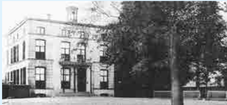
Huis na verbouwing.
