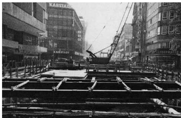
U-Bahn-Bau zwischen Kröpcke und Steintor
