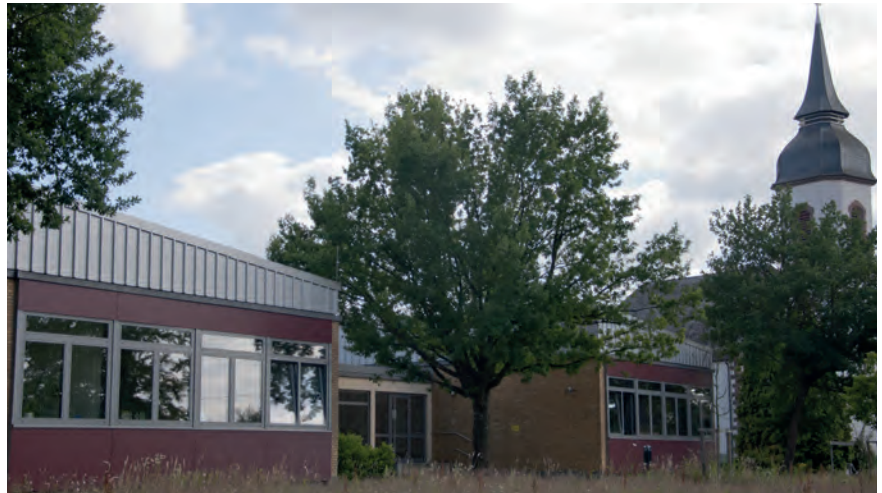
Kita Sonnenschein im Gebäude der ehemaligen Förderschule im Ortsteil Schaffhausen
