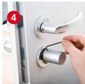
4 Befestigen des Drehknafs mit dem mitgelieferten Innensechskantschlüssel.
