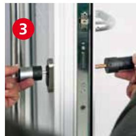
3 Anpassen an die Türstärke mit dem integrierten Rastsystem.
