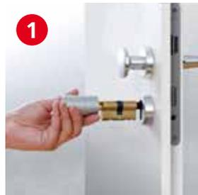
1 Vorhandenen Profil-Zylinder entfernen und den elektronischen TSE-Profil-Zylinder von der Außenseite einsetzen.
