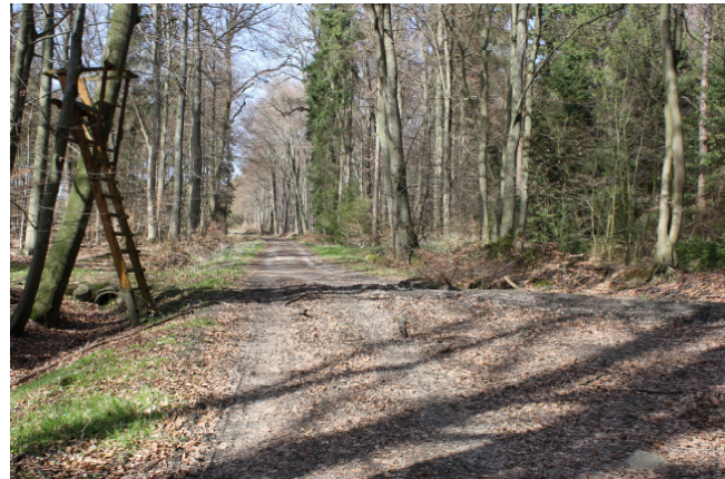
Abschnittsweise sanierungsbedürftiger Waldweg in Rulle
