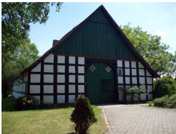
Gebäude in Alt Wallenhorst mit schwarzem Fachwerk und hell verputzten Gefachen sowie holzverkleidetem Giebeldreieck
