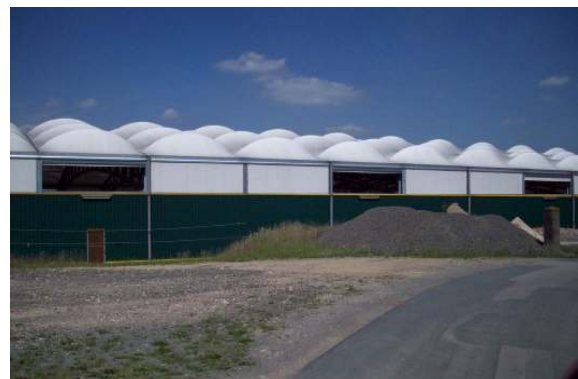
„Moderne“ wenig ortsbildprägende Reithalle in Rulle
