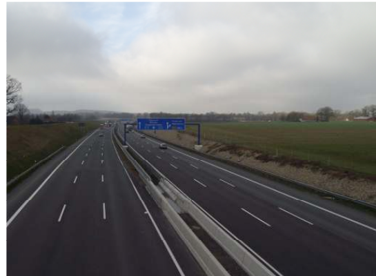
Autobahn A1 von der Brücke „Steinkamp“ mit Blickrichtung nach Süden
