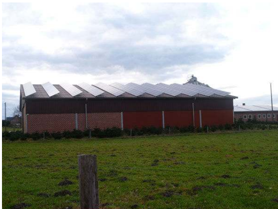
Stallgebäude mit Solaranlage
