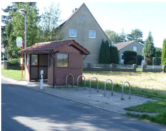
Buswartehaus an der Straße „Ostenort“
