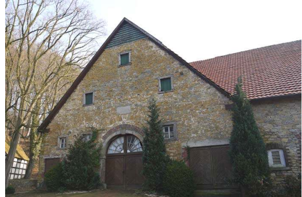
Typisches Bruchsteingebäude mit Sandsteineinfassung der Fenster- und Türöffnungen in Rulle
