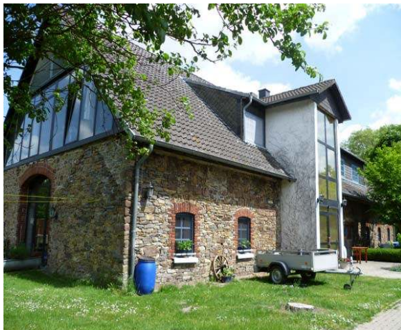
Durch Anbauten und untypische Fensterformate verändertes Bruchsteingebäude in Rulle
