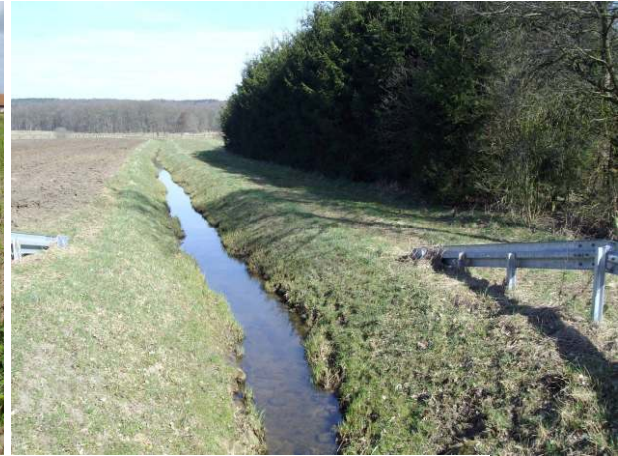
Nördlicher Abschnitt Bruchbach
