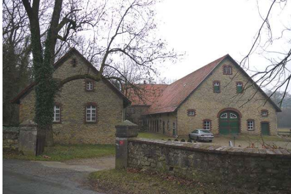
Typische Hofstelle mit Bruchsteingebäuden und -mauer in Rulle
