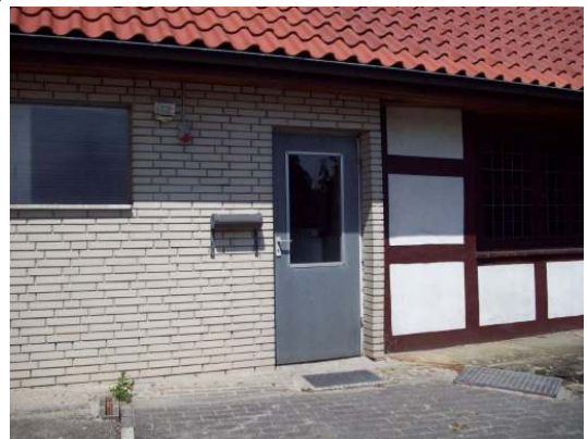
An- und Umbauten mit untypischen Fensterformaten und Materialien verändern das Erscheinungsbild der ursprünglichen Fassade
