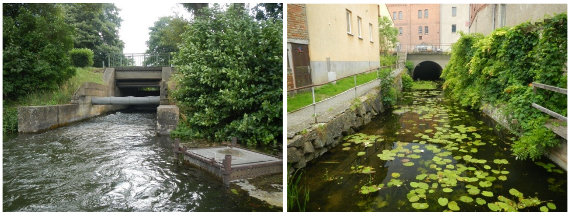
Abbildung 7-1: Auslauf Wehr Floßarche in den Stadtsee, rechts Mühlengraben Einlauf Richtung Mühle.
