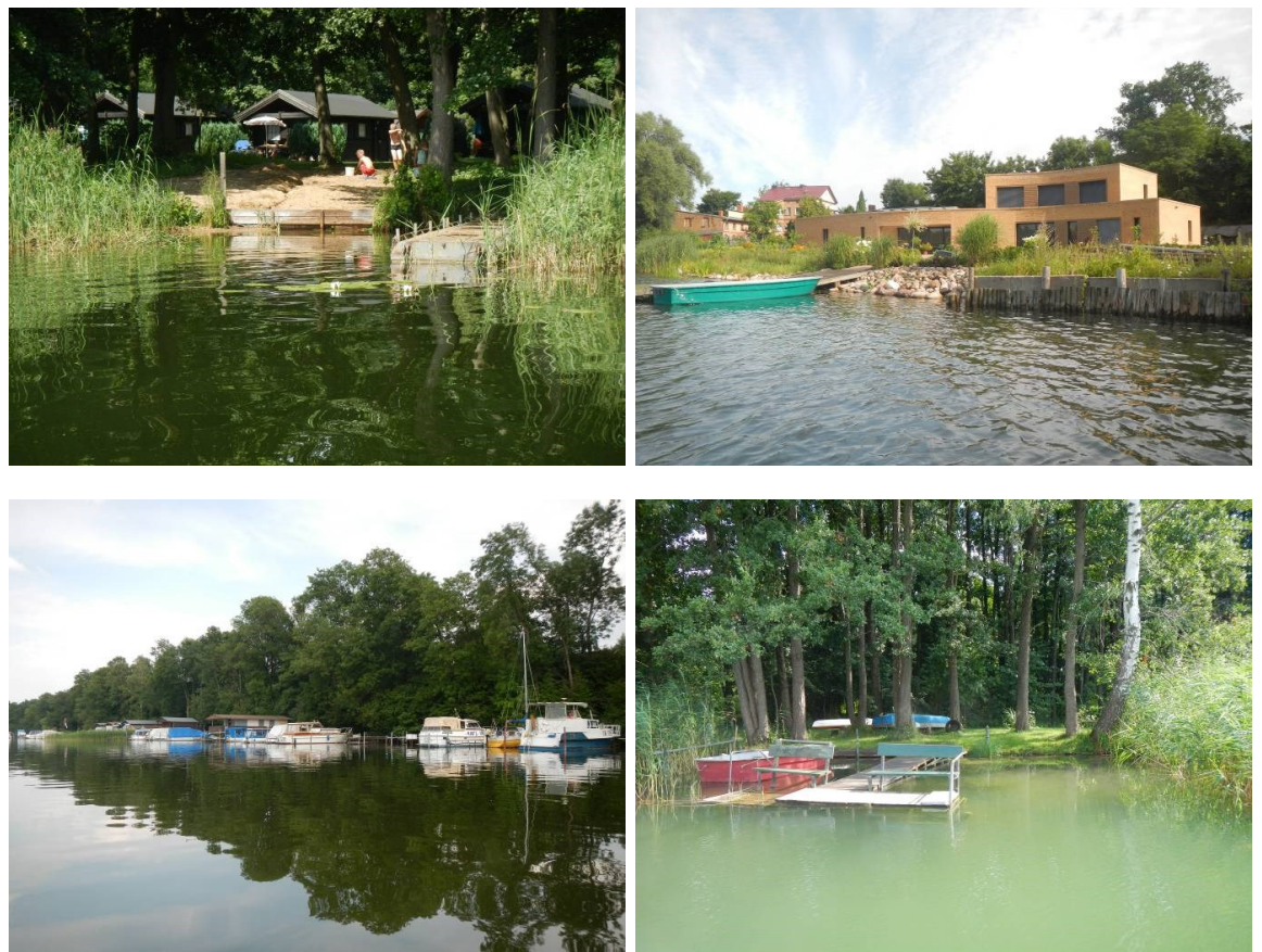
Abbildung 6-9: Beispiele für typische Schadstrukturen im Eulitoral: oben links: Badestelle mit senkrechtem Holzpalisadenverbau und Schwimmsteg einer Dauercampinganlage ( I_{Obj} = 3,5 , Fährsee); oben rechts: senkrechter Uferverbau mit Betonmauer, daneben schräge Uferbefestigung mit Blocksteinen und Steg ( I_{Obj} = 4,5 , Stadtsee Lychen); unten links: Reihe von Anlegestegen und Bootshäusern ( I_{Obj} = 3,5 , Röddelinsee); unten rechts: einer von zahllosen Einzelstegen mit Nutzung der Uferwiese ( I_{Obj} = 3,5 , Gr. Warthensee); Fotos: D. Futterer 2013.
