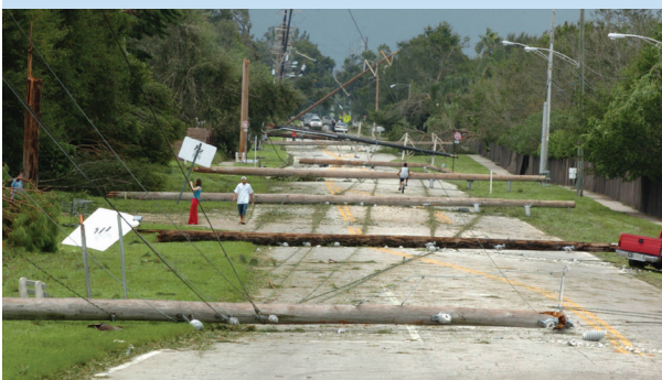
Daños por vientos del Huracán Charley, agosto de 2004, Orlando, FL/Orlando Sentinel, derechos de autor en 2004
