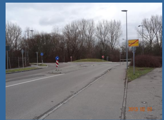
Maßnahme L2 Dammbalkenverschluss Kreisel Wert
