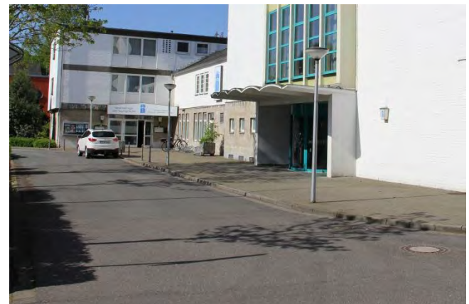
Abb. 46: Unattraktive, monoton gestaltete Eingangssituation der Festhalle Foto: Planungsgruppe MWM 2016.
