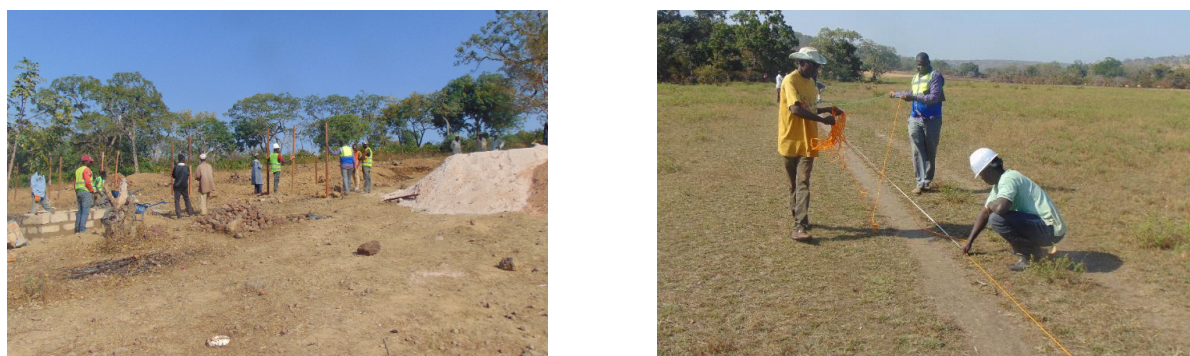
Figure 63 : Travaux de construction du marché de Bellakouré (droite) ; travaux de pose de la clôture de la plaine de Lallabara (gauche)
