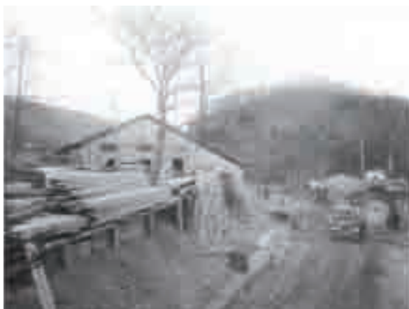
Foto 15 - La segheria della Soc. Feltrinelli alla Maestà di Cerreta. Sullo sfondo si intravede la Cappellina tuttora esistente. Archivio CFS/UTB Pratovecchio.
