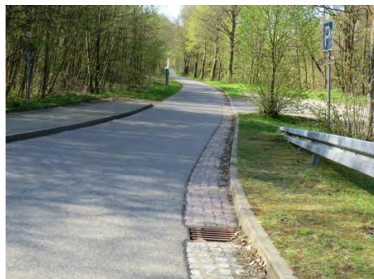
Abb. 6: Talstraße in Schönborn-Dreiwerden
