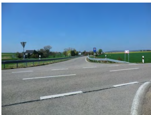
Abb. 3: Querung B 107 östl. Göppersdorf
