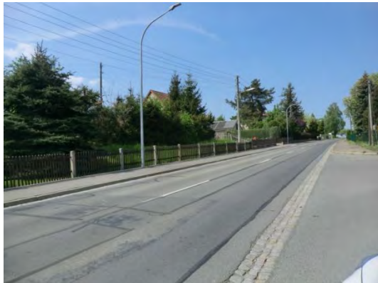
Abb. 1: Staatsstraße S 34 in Zscheplitz
