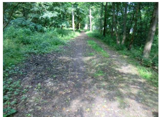
Abb. 8: aufgeweicherter Untergrund am Frelsbach
